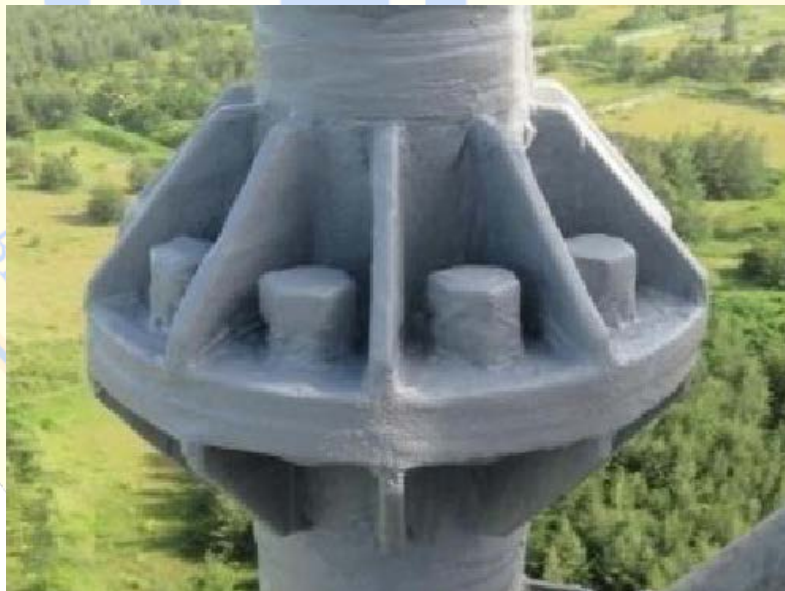
图 9.2-5 氧化聚合型包覆防腐层的应用
