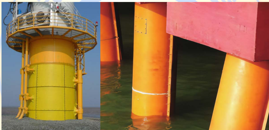
图 9.2-3 复层矿脂包覆防腐层的应用
